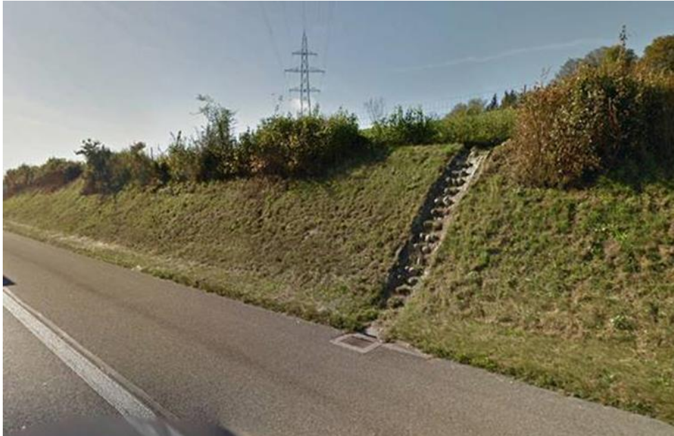
Abbildung 75: Gepflasterte Abflussrinne zur gezielten Fassung von Oberflächenabfluss (Beispiel bei km 3+14)
