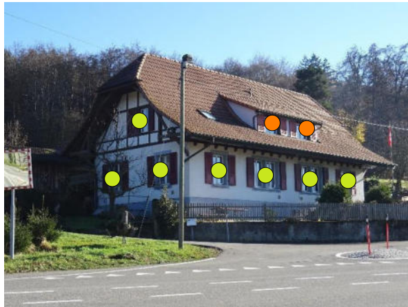
Nord- und Westfassade
