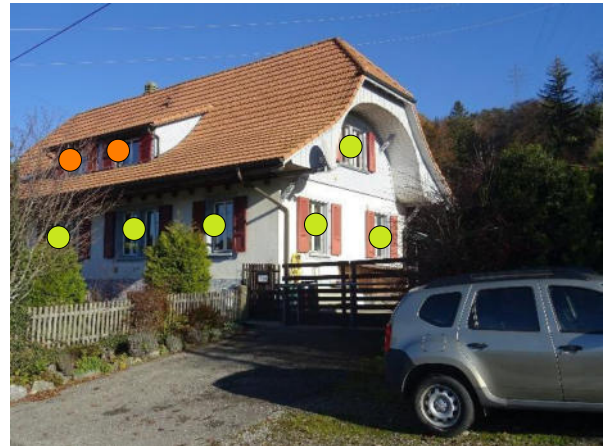
West- und Südfassade
