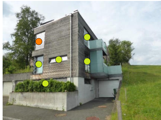
Nordost- und Nordwestfassade
