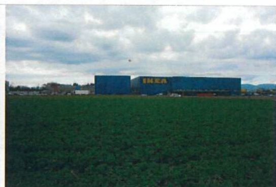
Abbildung 4 Übersicht Parz. 338, Blick Richtung Nordwest
