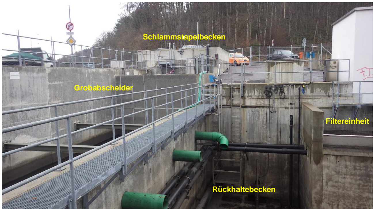
Abbildung 23: Vergleichsanlage SABA Halenbrücke (N01, Bern-Nord)
