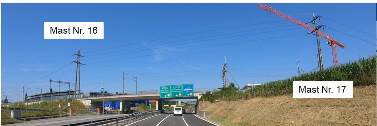
Abbildung 4: Bahnstromversorgungsleitung Fahrtrichtung Biel
