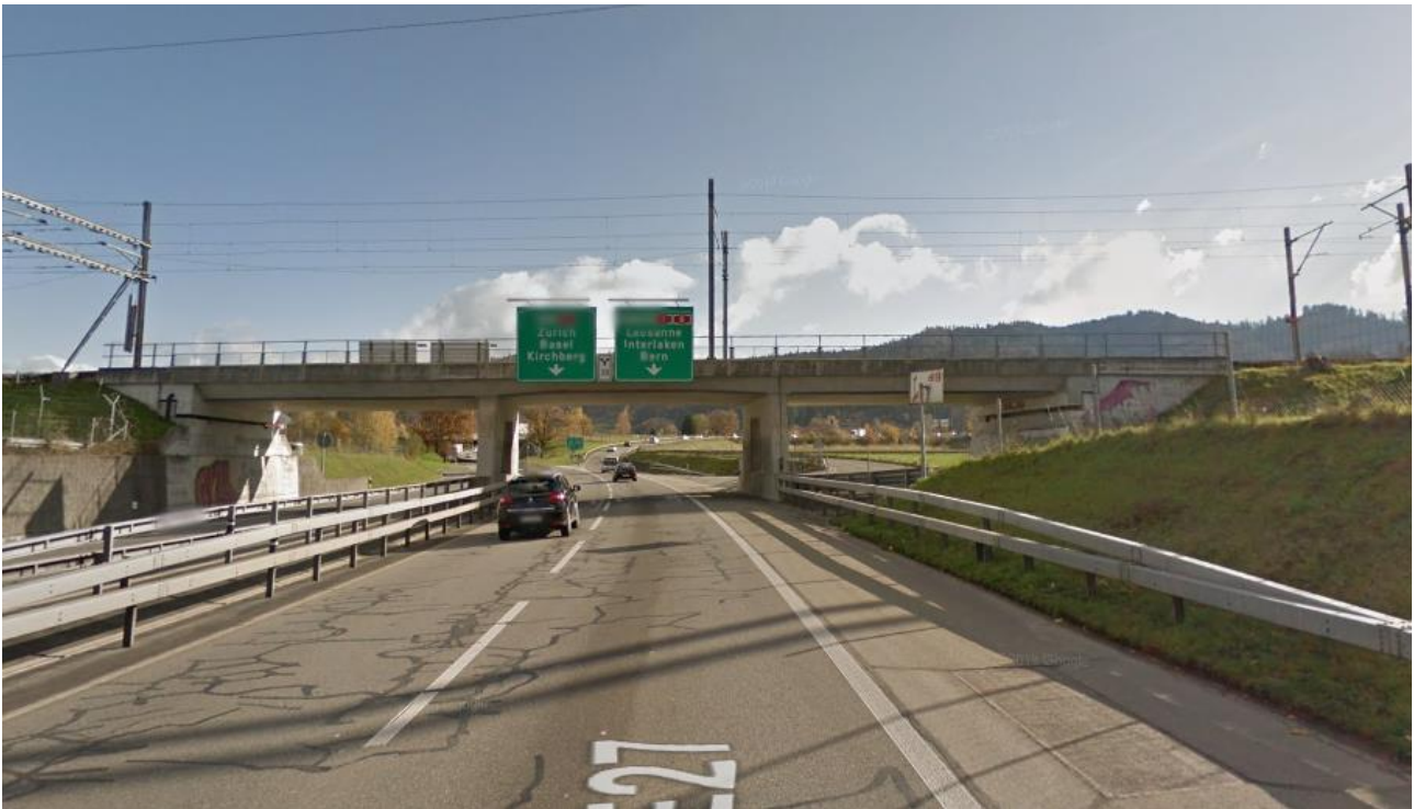
Abbildung 17: bestehende Signalisation an UEF SBB im Sand in Fahrtrichtung Bern
