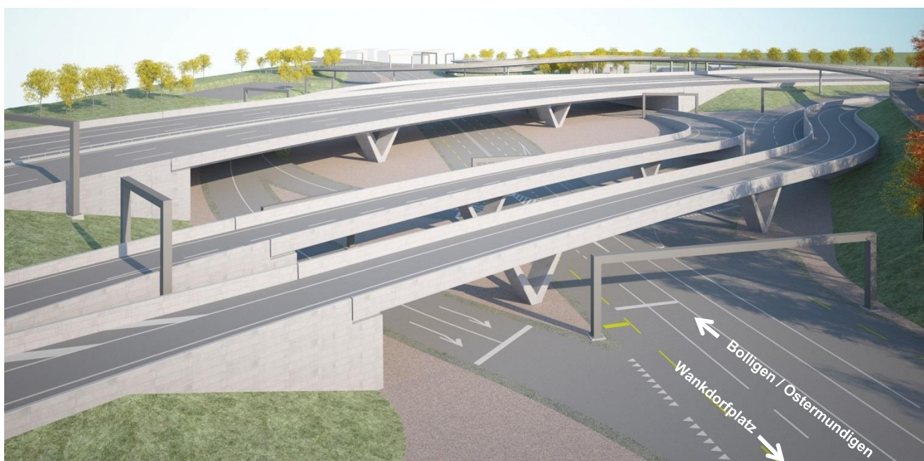
Abbildung 50: BRÜCKE Schermenweg T 03, mit den Rampenbrücken Mitte T 03B und West T 03C im Vordergrund
