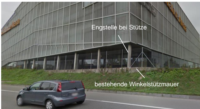
Abbildung 26: Ansicht PostFinance Arena an Engstelle bei Stütze Nr. 7
