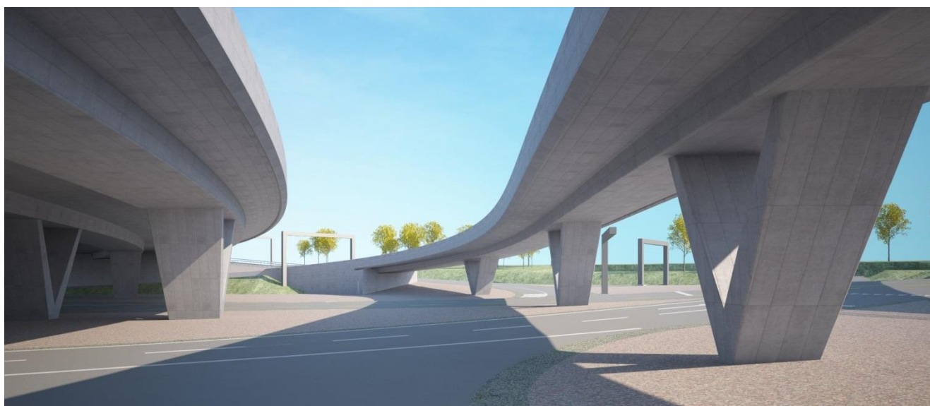
Abbildung 51: BRÜCKE Schermenweg Ost T 03A (rechts)
