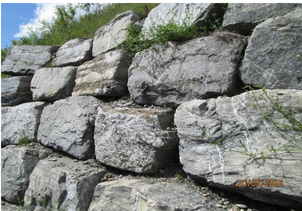
Blocksteinmauer bei Nationalstrassenauffahrt
