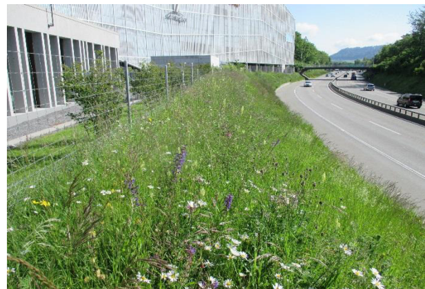
Abbildung 12: Artenreiche Böschung mit Trockenzeigern
