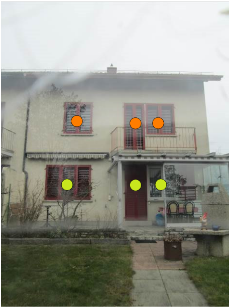
Südwestfassade (die übrigen Fassaden ohne Überschreitungen)
