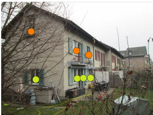
Nordwestfassade / Südwestfassade (übrige Fassaden ohne Überschreitungen)
