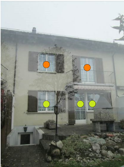
Südwestfassade (einzige Fassade mit Überschreitungen)
